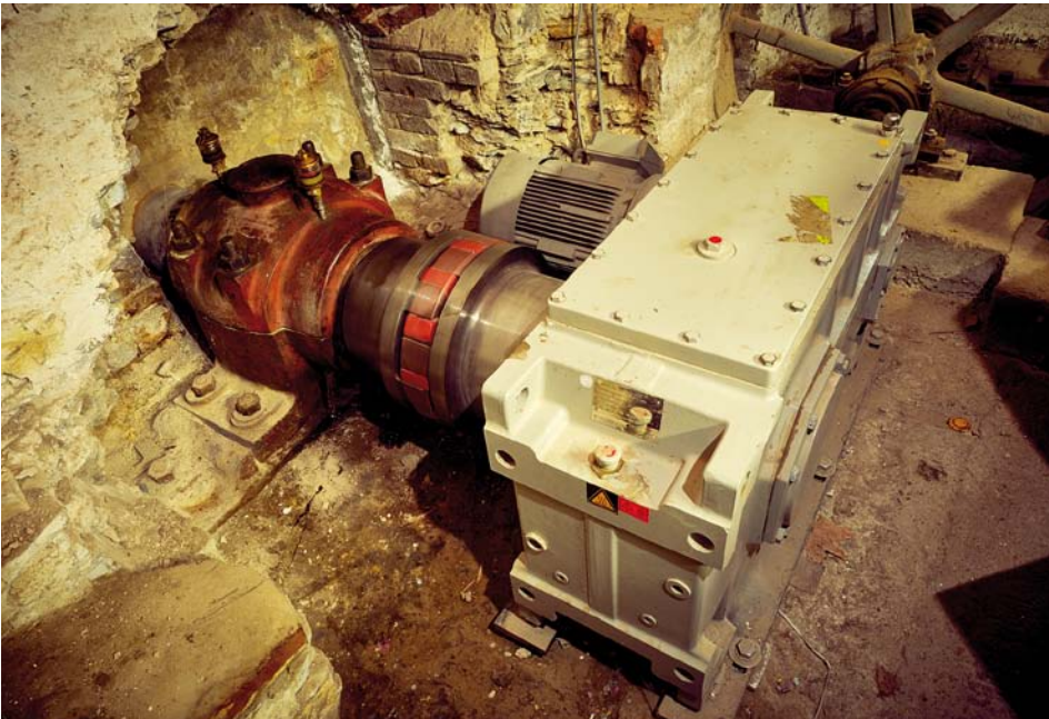
Abb. 7: Der Generator befindet sich heute hinter einer Glasscheibe und kann von dem Café aus betrachtet werden. Hintergrundmusik im Café übertönt das Brummen des Generators.
