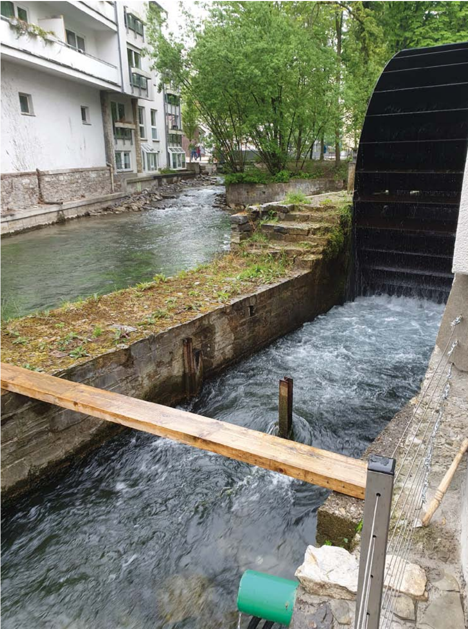
Abb. 6: Auslaufkanal des Wasserrades mit Blick entgegen der Fließrichtung. Lediglich die zwei schwarzen Leitungen am unteren Rand des Bildes deuten darauf hin, dass sich ein Wärmetauscher auf der Gewässersohle befindet.
